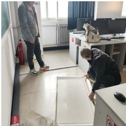
图6 更换机房纱窗
